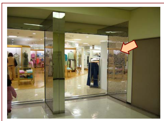
▲ 常時開放式防火門案例，該類門扇應與消防設備火警警報系統連動。
