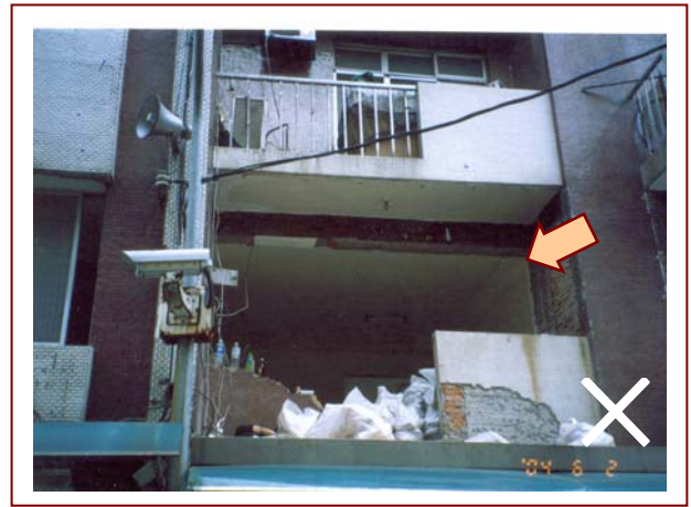
▲ 擅自拆除外牆，將「陽臺外推」已涉及違章建築行為。
