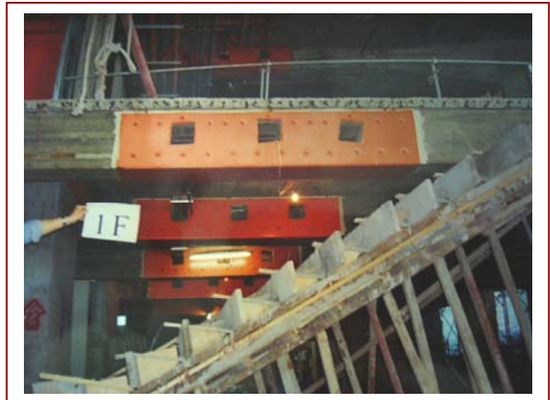
▲ R.C.樑因配線穿孔，採加勁鋼板補強並申請「變更使用執照」案例。
