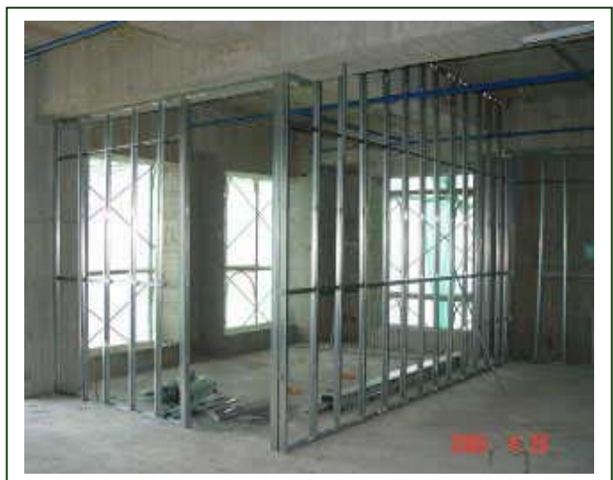
▲ 輕鋼架隔間牆具有良好的防火、防潮、耐撞擊力、耐震性，隔音效果佳。（施工中案例）
