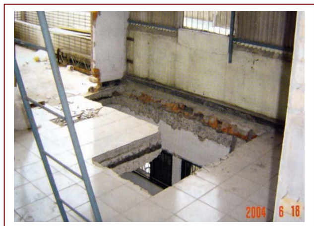
▲ 拆除樓地板涉及主要構造之變更，已逾越室內裝修管理範疇
